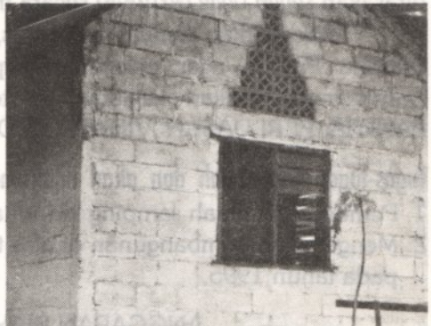
setelah selesai dibangun
