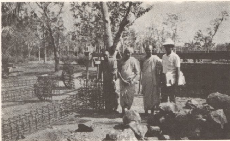
Para Y.A. disertai Romo Heru selaku pengawas bangunan sedang memeriksa besi beton yang akan segera di pasang.
